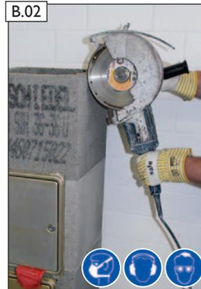
B.02 Mit Winkelschleifer Öffnung herstellen.
