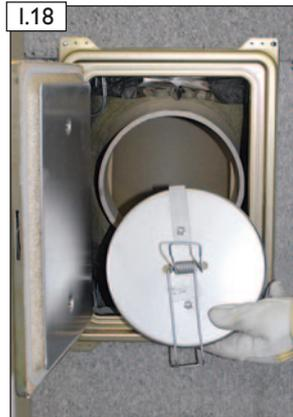
Revisionsverschluss „F“ für Festbrennstoffbelegung einsetzen.
