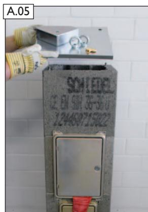
A.05 Versetzösen und Schutzabdeckung entfernen.
