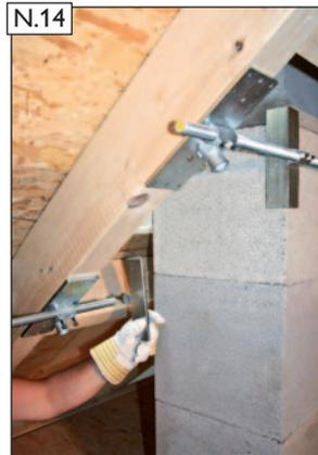
Gewindestange und Spannwinkel wieder ein-fädeln und ausrichten.
