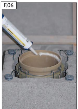
RAPID-fugendicht satt auftragen.
