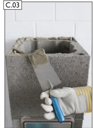
Mörtel MG(M5) Ila (Mauermörtel nach EN 998-2) auftragen.
