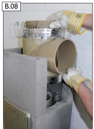
B.08 Rauchrohranschluss (RA) einsetzen.
