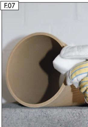
F.07 Unterseite zugeschnittenes Abschluss-Profilrohr (ohne Dämmschale) säubern.
