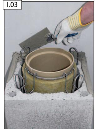
Mörtel MG(M5) IIa (Mauermörtel nach EN 998-2) auftragen.
