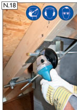
Bei Bedarf überstehende Gewindestangen an den Lagerbuchsen kürzen.
