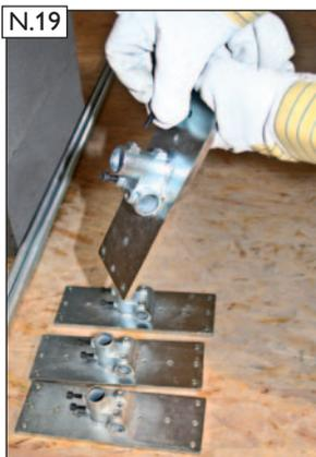
Beide Abreißschrauben an den Sparrenhaltern auf die senkrechte Lagerbuchse umschrauben.
