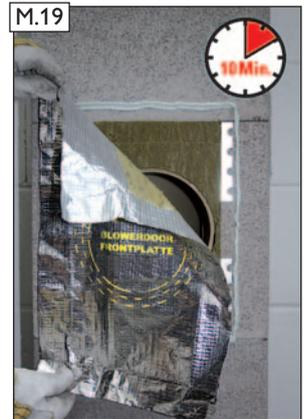
Spezial-Alugewebefolie innerhalb von 10 Minuten ausgerichtet ansetzen und ...
