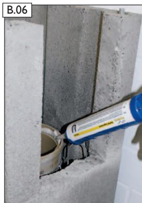
B.06 RAPID-fugendicht satt auftragen.
