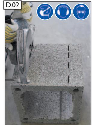
Mit Winkelschleifer Öffnung herstellen.
