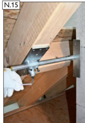
Gewindestange fixieren. Dazu die Abreißschrauben an beiden Sparrenhaltern mit Inbusschlüssel (E) anziehen bis der Schraubkopf an der Sollbruchstelle abreißt. Erst danach Spannwinkel fixieren (siehe Bild N.09).
