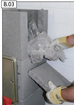
B.03 Bauseitige Schutzabdeckung entfernen.
