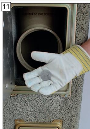
11 Grobfilter aus der Ablauföffnung im Kondensatteller herausnehmen und reinigen. **WICHTIG!** Rußablagerungen dabei ggf. vorher aus dem Kondensatteller entfernen!
