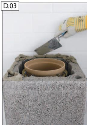
Mörtel MG(M5) IIa (Mauermörtel nach EN 998-2) auftragen.
