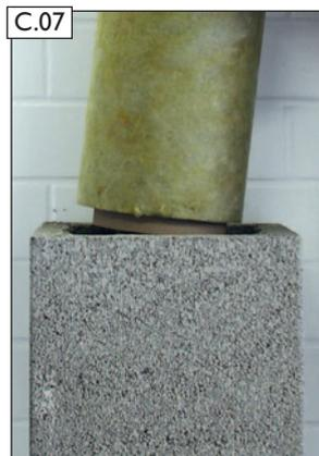
Profilrohr (66 cm) einsetzen.
