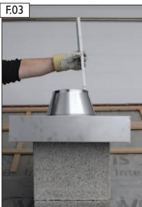
Zuluftkopfplatte und Abströmkonus lose auflegen und Zuschnittlänge für Abschluss-Profilrohr (ohne Dämmschale) ermitteln.
