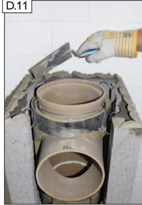
Mörtel MG(M5) Ila (Mauermörtel nach EN 998-2) auftragen.
