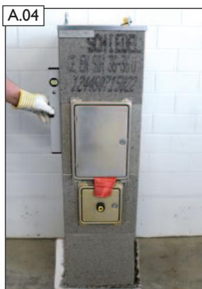
A.04 Fertigfuß in Mörtel MG(M5) Ila (Mauermörtel nach EN 998-2) versetzen und lotrecht ausrichten.
