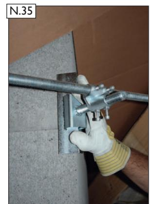
45° Spannwinkel ausrichten und vorfixieren.
