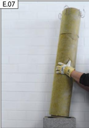
Profilrohr 133 cm einsetzen.
