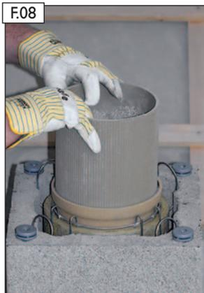
F.08 Abschluss-Profilrohr (ohne Dämmschale) versetzen.
