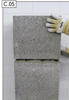
1 Mantelstein (bei Profilrohr 66 cm) in Mörtel MG(M5) Ila (Mauermörtel nach EN 998-2) versetzen.
