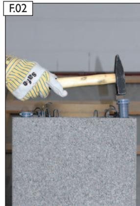
HEB-Spezialdübel in die Bewehrungskanäle des Mantelsteins einschlagen.
