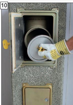
10 Putztür öffnen und Revisionsverschluss abnehmen. (Bild Darstellung am Beispiel ABSOLUT-Revisionsverschluss „B“)
