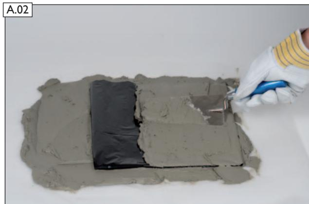
A.02 Mörtelbett vorbereiten, Feuchtesperre einlegen, Mörtel MG(M5) Ila (Mauermörtel nach EN 998-2) auftragen.
