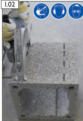
Mit Winkelschleifer Öffnung herstellen.
