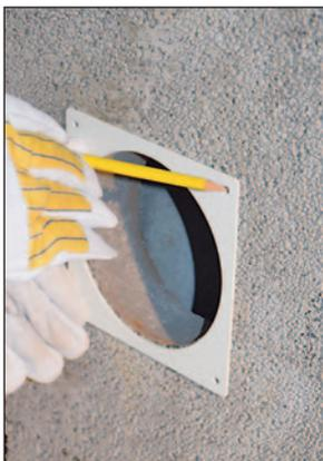
Markierung für Bohrlöcher anzeichnen und herstellen.
